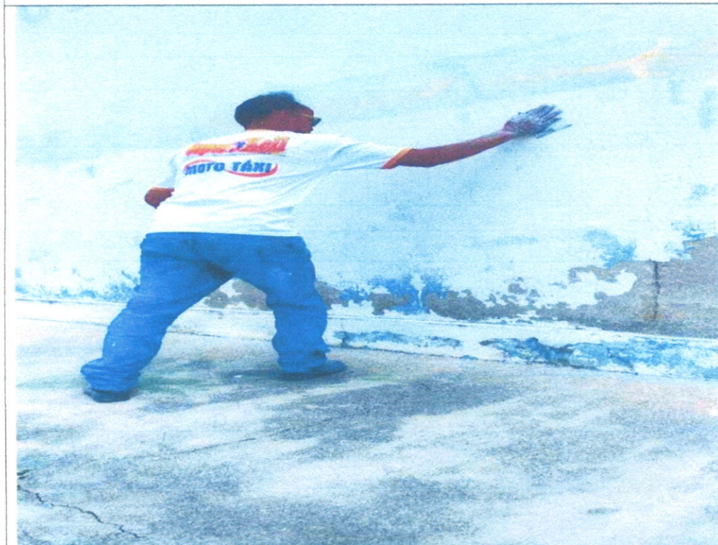
Preparação de superfície
