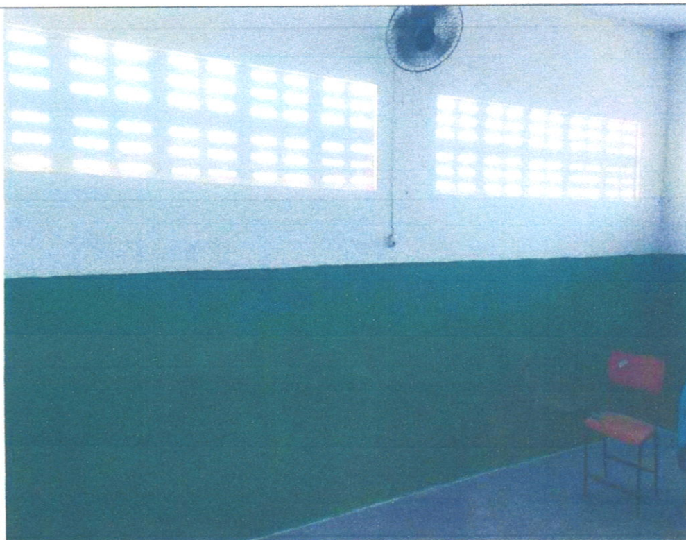
Aplicação de pintura
