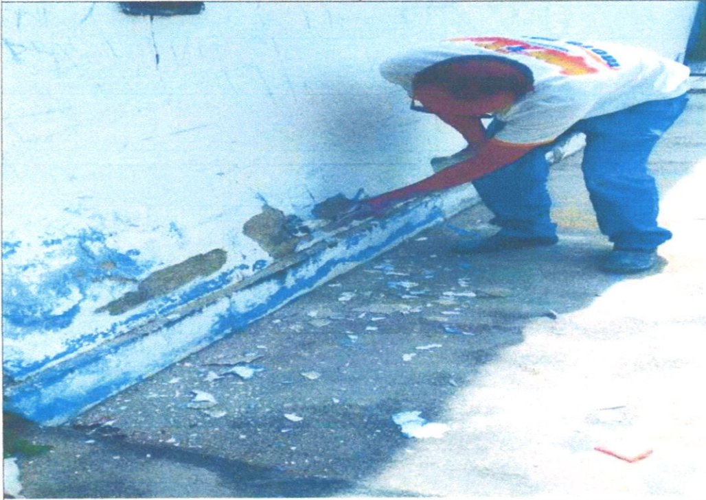
Preparação de superfície
